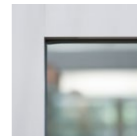
Détail du châssis : dormant-ouvrant
