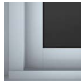
Détail ext. : partie inférieure drainage caché
