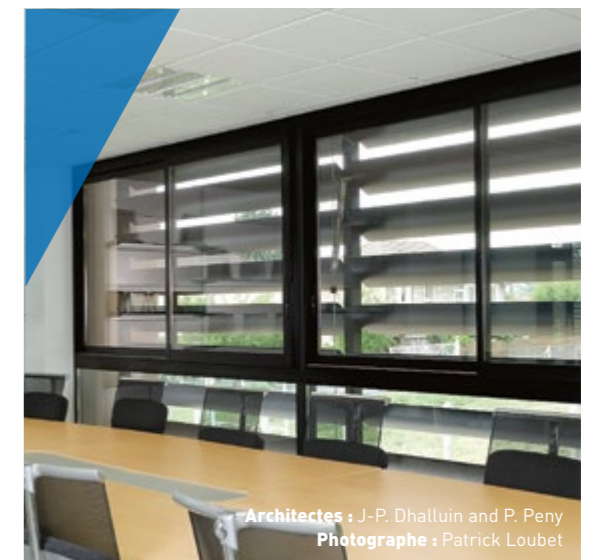
Lames de 300 mm motorisées - Inclinaison 45°
